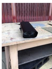
図1. カメラ設置状況
